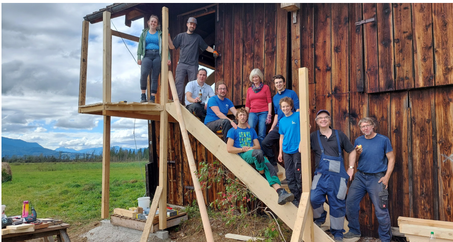
Alle packen mit an: Reparaturen und neuer Aussichtsstand am Moorstadl
